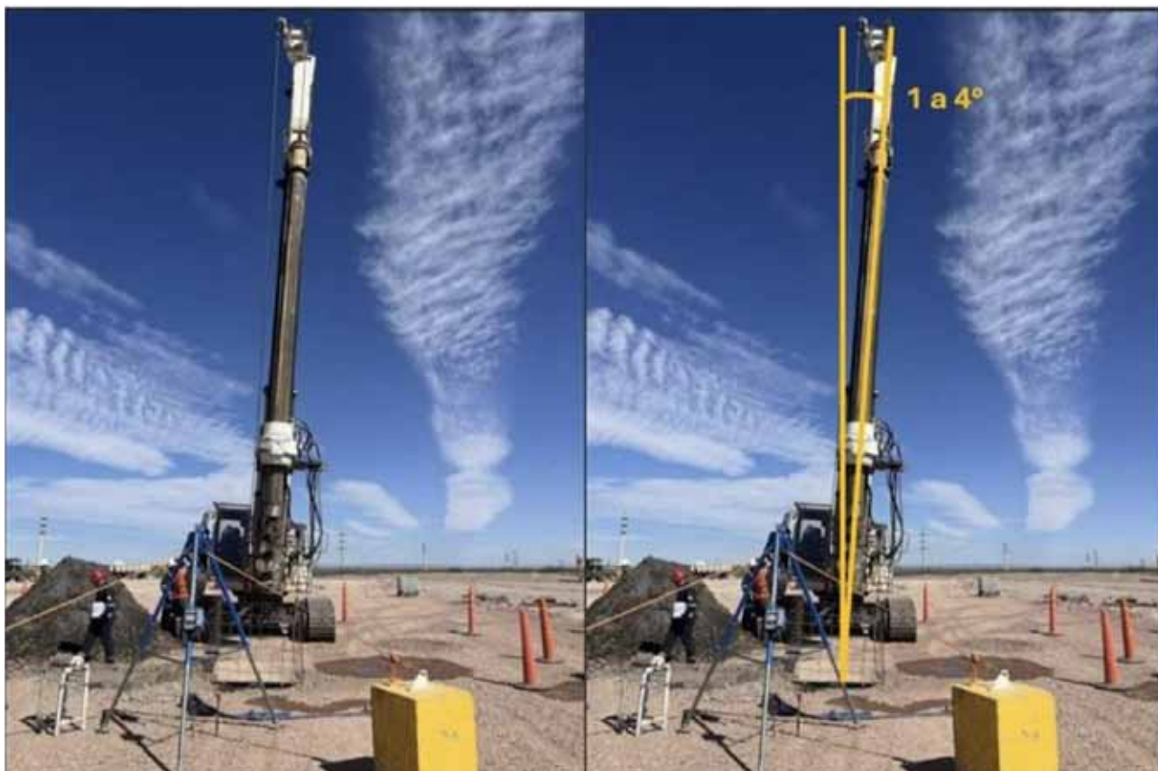
Imagen 17. Desvío con torre maquina piloto con placa niveladora.
