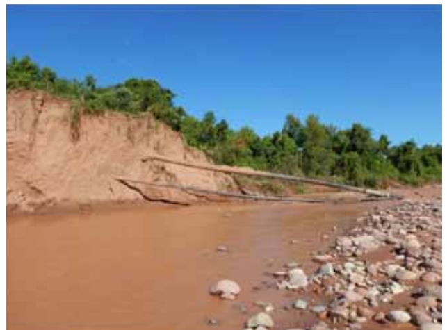
Figura 4. Erosión de margen con destape de cuello de cisne
