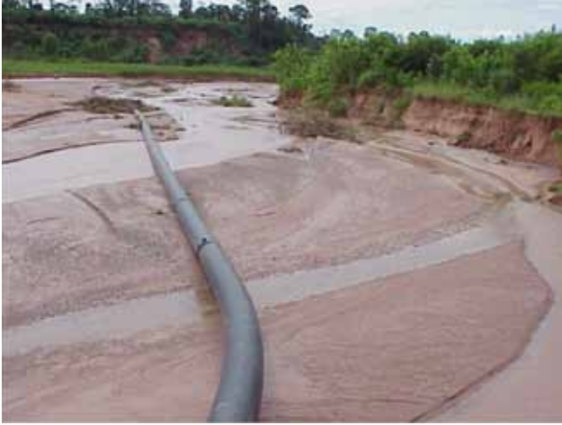
Figura 5. Erosión de margen por meandro con destape de cuello de cisne
