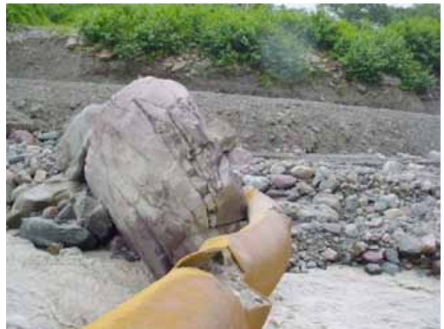
Figura 9. Impacto de rocas transportada por el flujo de barro en un bypass expuesto
