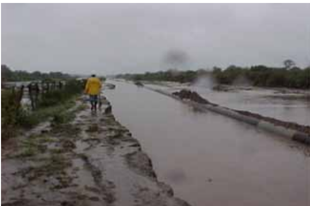
Figura 7. Fuga del río por la pista con el ducto sometido a la corriente de agua y a la flotación
