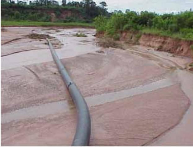
Figura 5. Erosión de margen por meandro con destape de cuello de cisne
