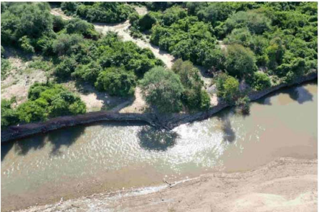
Figura 15. Erosión de margen y desmoronamiento parcial de la obras de protección en 2022, en margen norte o izquierda
