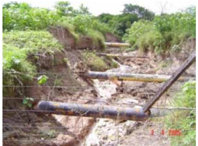
Figura 3. Descenso generalizado del lecho por erosión aguas debajo de una alcantarilla
