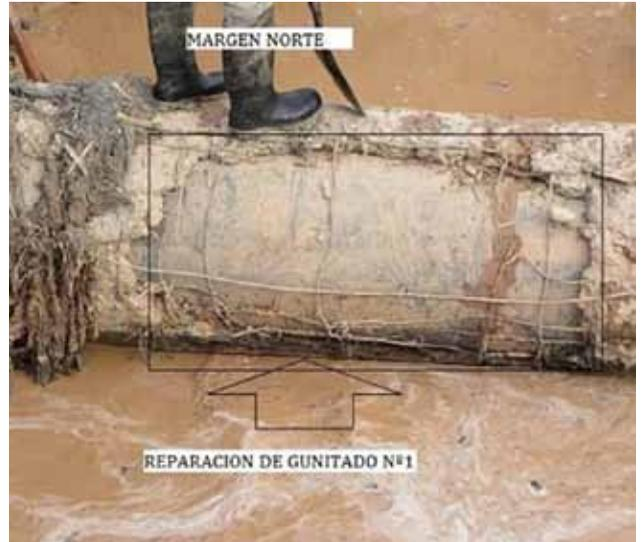
Figura 8. Daños en el contrapesado de hormigón por impacto de rocas por acarreo de fondo
