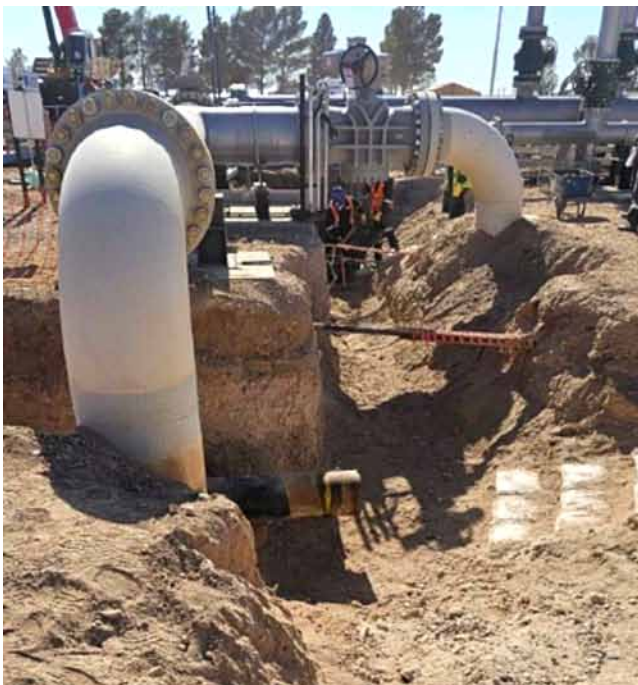
Retiro de reparación provisional y cambio de tramo.
