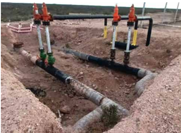
Obras civiles post intervención.
