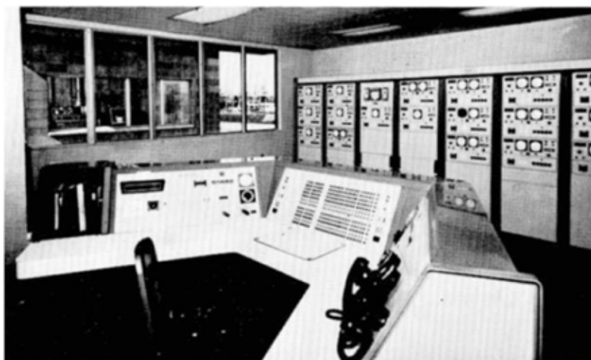
Figura 3. Sala de control y sala de analizadores adyacente en el fondo en la década de los 60'.
