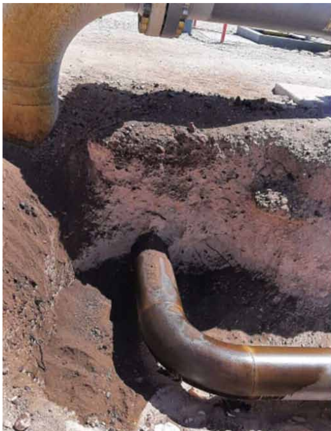
Pérdida de contención y colocación de reparación provisoria.
