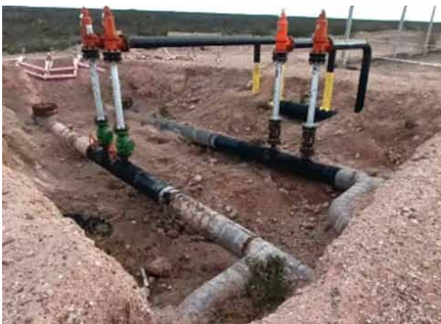
Obras civiles post intervención.
