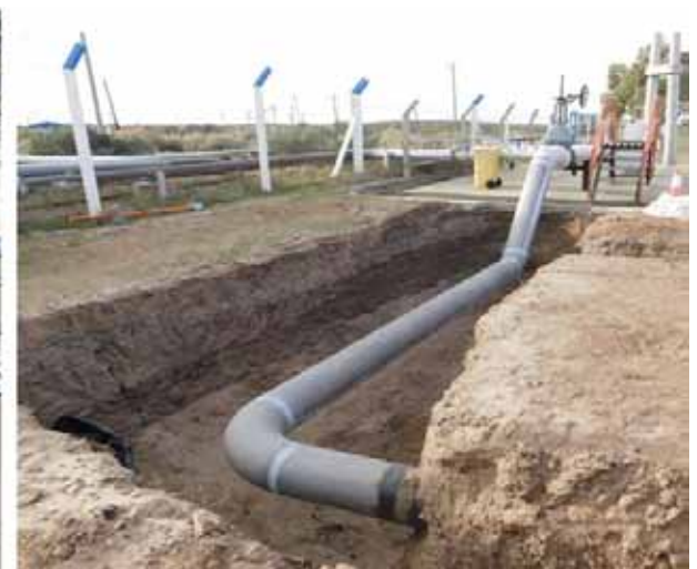
Excavación y acondicionamiento superficie.
